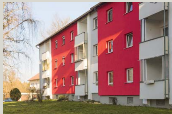
Eines der renovierten Wohnhäuser des verkauften Portfolios Zanger Berg
